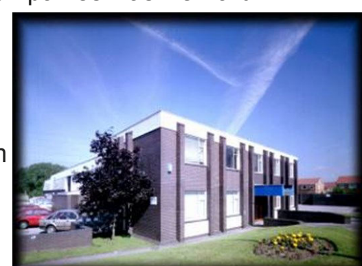
VG Altrincham Facility c.2000
